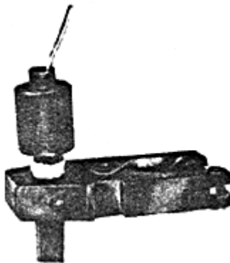
Рис. 17. Введение присадочного прутка из алюминиевой проволоки в кокиль термитного патрона марки АС при сварке алюминиевой жилы кабеля со стальным стержнем
